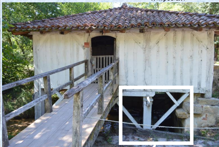
Photographies personnelles, moulin basque équipé d'une roue horizontale
